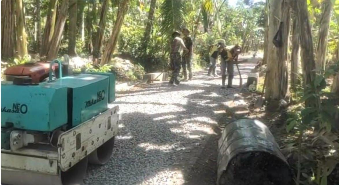
Dari pantauan kami dilapangan pengerjaan pengerasan jalan sudah mencapai lebih dari 80 persen, dengan percepatan yang dilakukan mungkin dalam Minggu ini Pengerasan jalan dapat diselesaikan.
